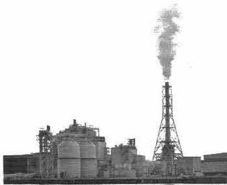
仙台市宮城野区の石炭火力発電所＝10月28日
