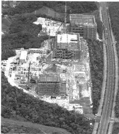
学校法人「加計学園」が獣医学部新設を予定している建設現場＝7月、愛媛県今治市
